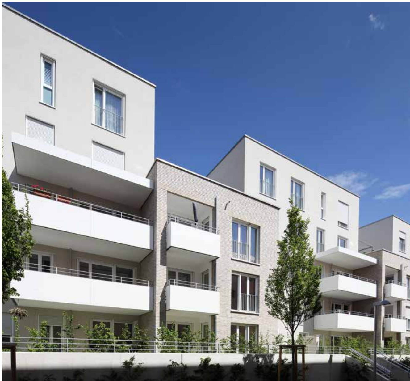
Abbildung oben: Mehrfamilienhaus in Ulm
